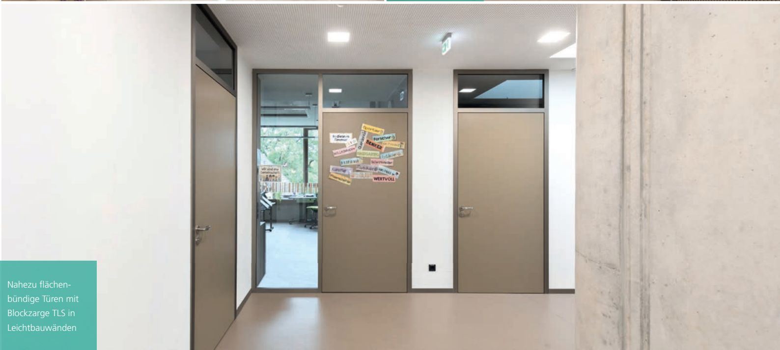
Aluminium- Blockzarge TLS mit Glasseitenteil und Oberlicht
